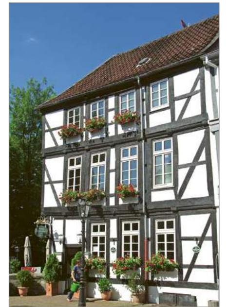
**Bild 9: Großer Zimmerhof 13: Bauzeit 1. Hälfte 19. Jh. Ansicht zum Großen Zimmerhof hin. Dreigeschossiger Fachwerkbau in Stockwerkbauweise. Obergeschosse leicht vorspringend. Aussteifung der Fassade durch Streben.**
