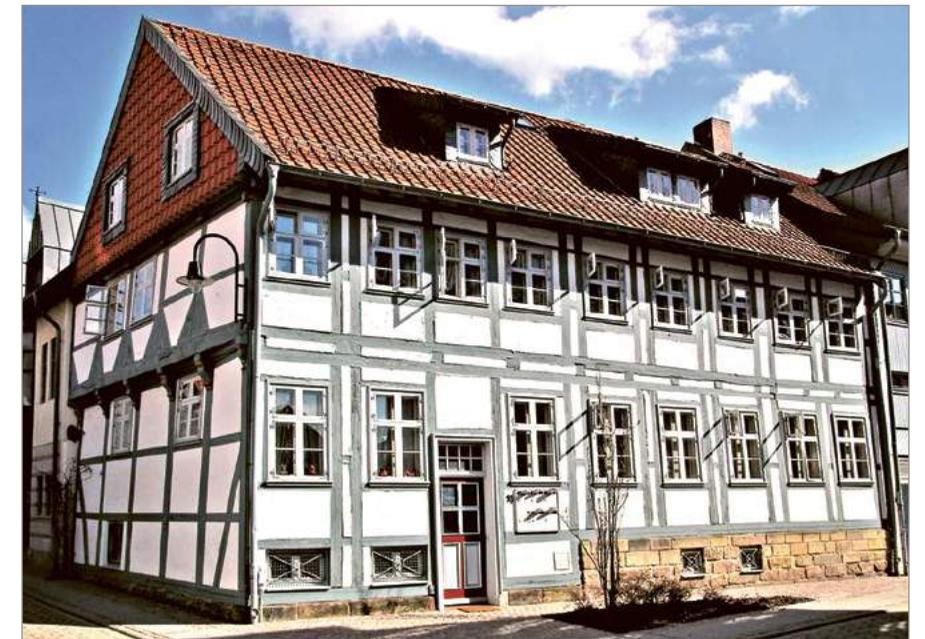
**Bild 10: Lustgarten 10: Bauzeit 2. Hälfte 17. Jh. Konstruktion der Fassade mit Doppel- und Einfachstiele ohne Aussteifung durch Streben oder andere Elemente.**
