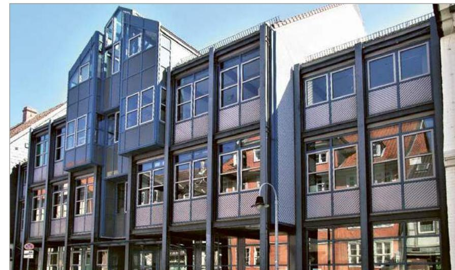
**Bild 15: Modernes Fachwerk des 20. Jahrhunderts. Harzstraße 4+5. Kreisvolkshochschule. Bauzeit 1993. Durch die sichtbaren Stahlstützen wird das Konstruktionsprinzip des Fachwerkbaus in moderner Weise aufgenommen.**
