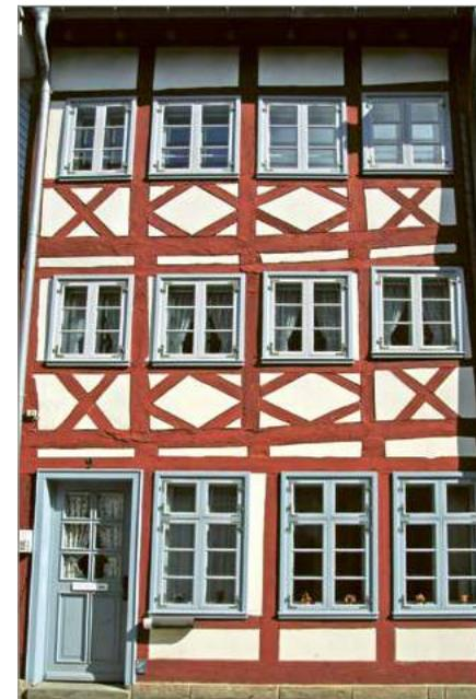
**Bild 8: Lustgarten 9: Bauzeit 2. Hälfte 18. Jh. Aussteifung der Fassade durch Andreaskreuze und Rauten.**
