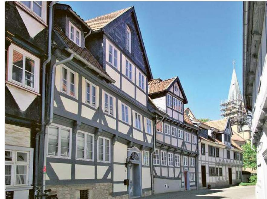
**Bild 4:** Krumme Straße: Fachwerkhäuser in traufständiger Bauweise. Die Häuser stammen aus der 2. Hälfte des 17. Jh. Ausgebaute Dachgeschosse mit Schleppdachgauben und Zwerchhaus. Fotos: Prof. Axel C. Toepfer
