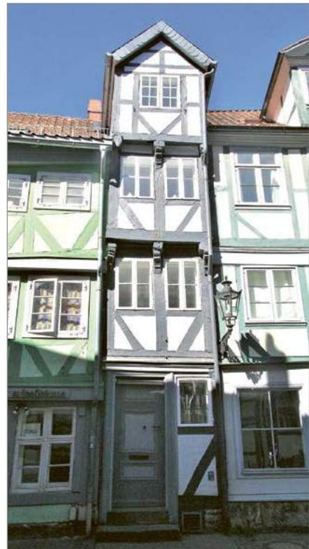
**Bild 6: Kleiner Zimmerhof 15: Baujahr 1751. Schmalstes Fachwerkhaus in Wolfenbüttel (Breite des Fundamentsockels 2,16 m). Dreigeschossiger Fachwerkbau in Stockwerkbauweise mit einem Zwerchhaus über die ganze Hausbreite. Aussteifung der Fassade mit Fußbändern. Obergeschosse auf Volutenknaggen vorspringend.**
