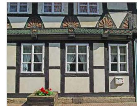
**Bild 13: Stobenstraße 5, linke Haushälfte: Bauzeit wohl 2. H. 16. Jh. Fußwinkelhölzer mit farbigen Fächerrosetten. Auf der Setzschwelle unterschiedliche Friesbänder, unterbrochen von Tierdarstellungen (Fisch, Hase) und Jägerhut über den auskragenden Balkenköpfen.**
