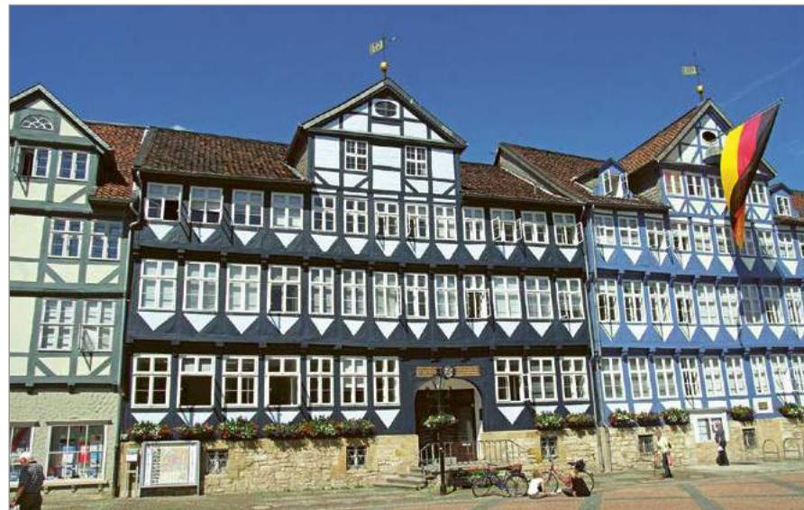
**Bild 7: Stadtmarkt 6; Rathaus: Bauzeit 1. Hälfte 17. Jh. Dreigeschossiger Fachwerkbau in Stockwerkbauweise mit einem Zwerchhaus. Obergeschosse auf Knaggen auskragend. Aussteifung der Fachwerkfassade mit Fußwinkelhölzern.**
