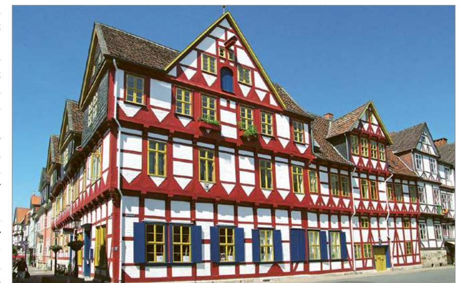
**Bild 5:** Stadtmarkt 14, Alte Apotheke: Bauzeit 1. Hälfte 17. Jh. Zweigeschossiger Fachwerkbau in Stockwerkbauweise mit einem Frontispitz und einem Zwerchhaus. Aussteifung der Fachwerkfassade mit Fußwinkelhölzern und mit Fußbändern. Im Frontispitz ein Kranbalken über einer Ladelupe.
