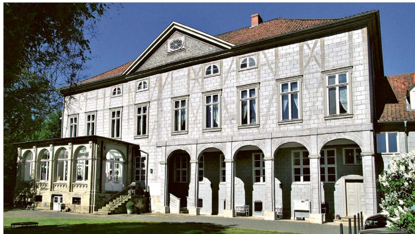
**Bild 11: Kleines Schloss, Schlossplatz 14: Bauzeit 1. H. 18. Jh. Fachwerkfassade mit aufgemalten Fugen, so dass der Eindruck einer gemauerten Steinfassade entsteht. Die Fachwerkstruktur ist noch schwach zu erkennen.**
