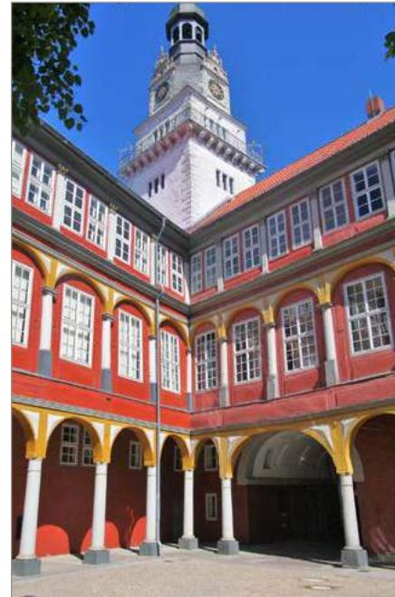
**Bild 2:** Fachwerkansicht vom Schlossinnenhof. Stützen, Bögen und Schwellen aus Holz. Gefache ausgemauert, geputzt und gestrichen. Durch die kräftige und dick aufgetragene Farbe ist die Fachwerkstruktur völlig überdeckt.
