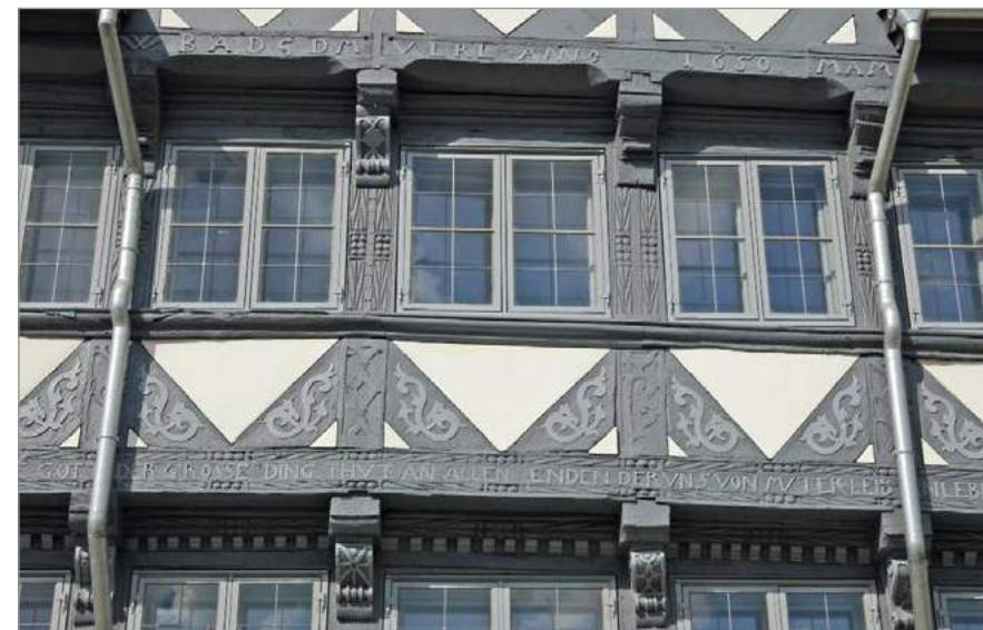
**Bild 12: Holzmarkt 14: Bauzeit 2. H. 17. Jh. Reich verziertes Fachwerk. Ständer bis in Höhe der Brustriegel mit Beschlagwerkornamentik. Fußbänder mit Grottesken. Obere Schwelle mit Diamantband und Perlstäben. Füllhölzer zwischen den Balkenköpfen der Deckenbalken mit Zahnschnitt. Reich ornamentierte, auch seitlich profilierte Volutenknaggen. Inschrift auf der Setzschwelle des Zwerchhauses: WBADSDMVLRL ANNO 1650 MAM Wer Baut An Der Straßen, Der Muß Viele Leute Reden Lassen.**
